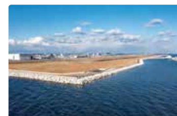
消波ブロック設置
