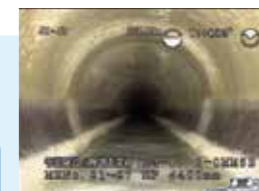
下水道管内部
