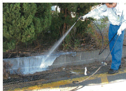
専門業者による液剤の高圧散布
