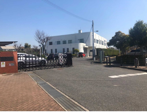
①敷地入口（南西から北東を望む）
