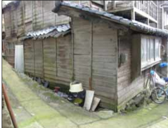
外壁が裸木造の例
