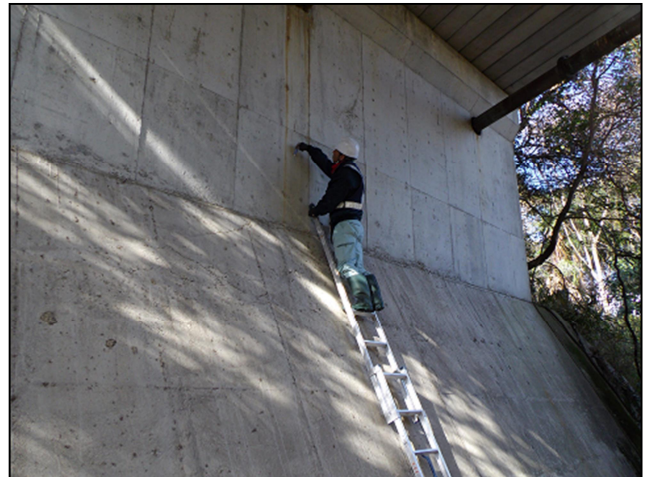
橋台の点検状況
