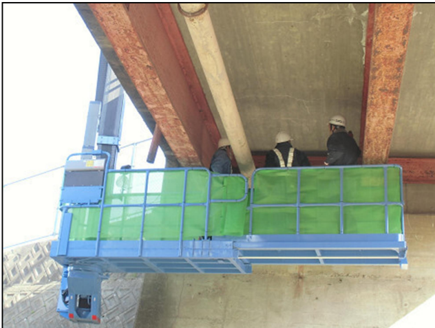
橋桁の点検状況
