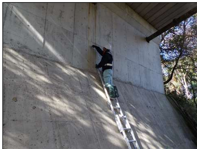
橋台の点検状況
