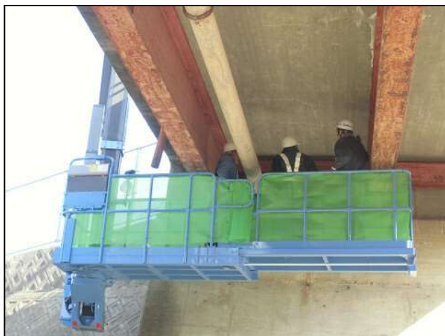
橋桁の点検状況
