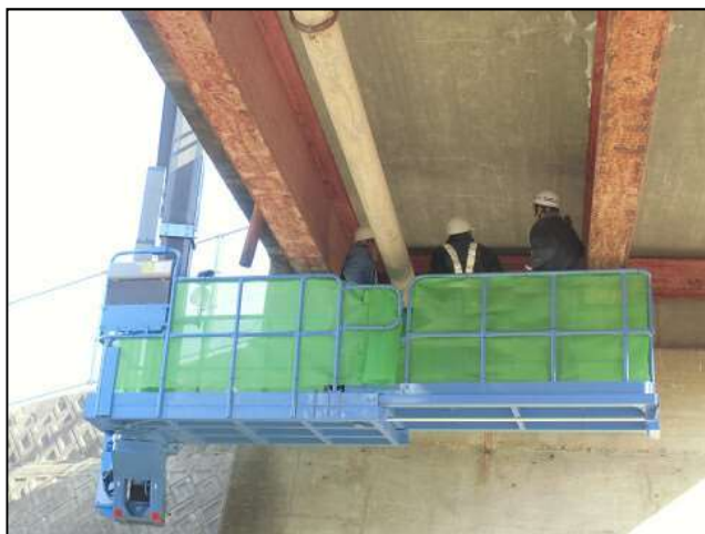
橋桁の点検状況
