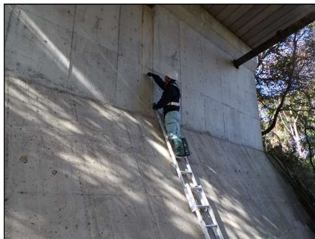
橋台の点検状況
