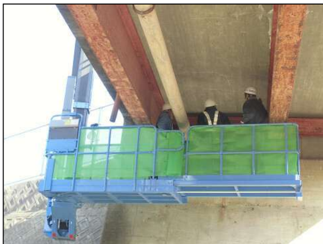
橋桁の点検状況
