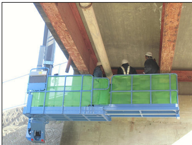
橋桁の点検状況
