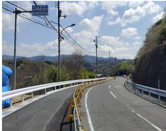
町道久保高田線（小谷南地区）（事業中）
