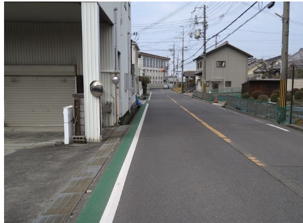
町道五門久保小谷線（令和2年度完了箇所）
