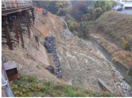
令和元年12月18日 土留め用大型土のう 設置完了状況
