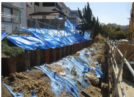
令和2年3月23日 土留鋼矢板打設後
