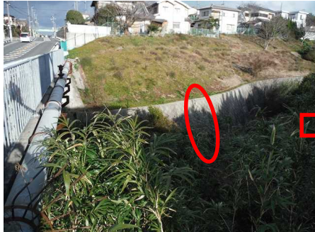
①被災以前のブロック積の状況
