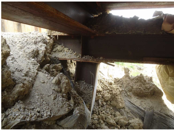
工事用道路端部における歪み発生状況
