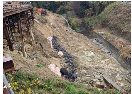
令和元年12月26日 土留め用大型土のう 滑り状況
