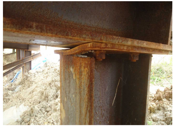
工事用道路端部における歪み発生状況
