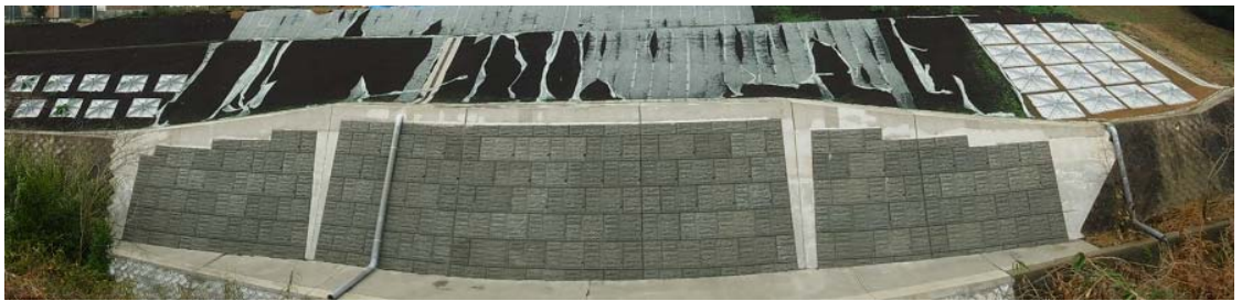
大型ブロック積全景写真
