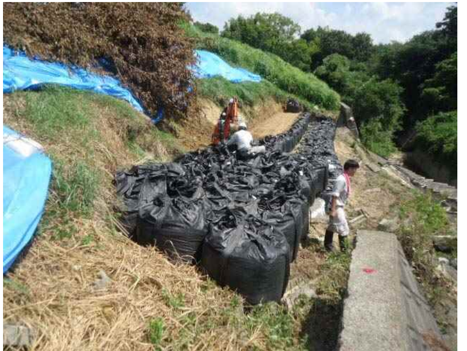
応急復旧工事完了後断面状況写真
