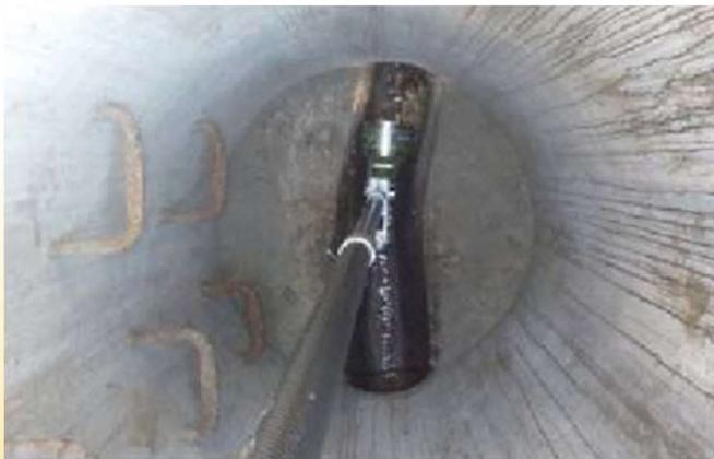
管口TVカメラの設置(人孔上部より)
