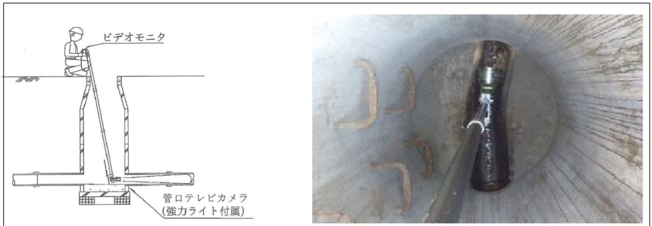
管口カメラ調査
