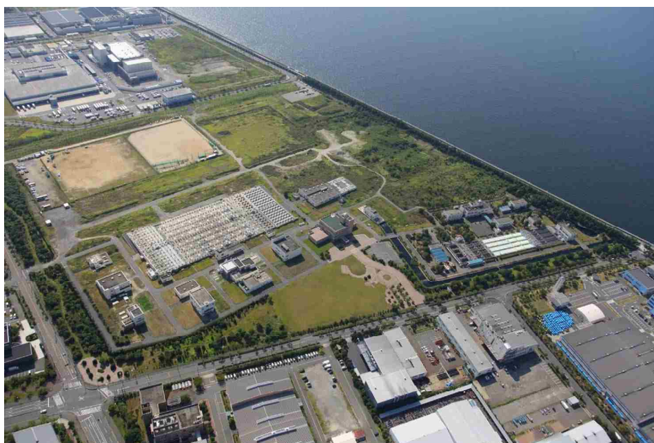
中部水みらいセンター
