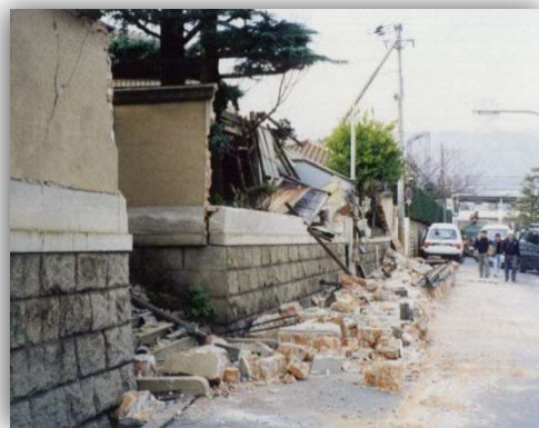
民家のレンガ造塀の倒壊 阪神・淡路大震災／平成7年（1995年） 写真提供：応用地質株式会社
