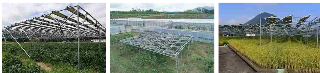
図 4-21 営農型太陽光発電システム (農林水産省HPより)
