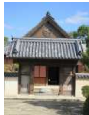
図40 耐震工事をした表門
