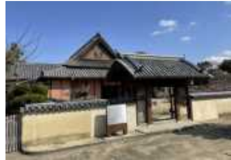
図17 重要文化財中家住宅
