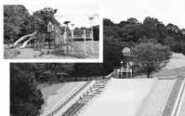
11月21日にOPEN! ※工事中の風景写真より
