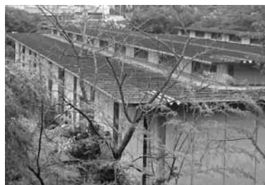
▲汚水処理場跡
