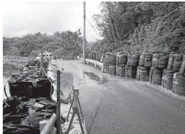
復旧した仮設道路
