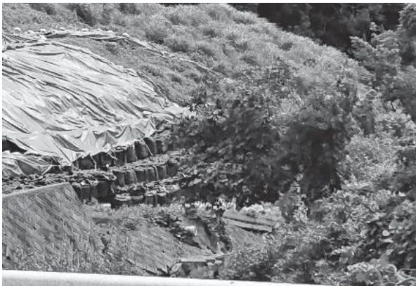
7月豪雨で崩壊した雨山川（美熊台地区）法面
