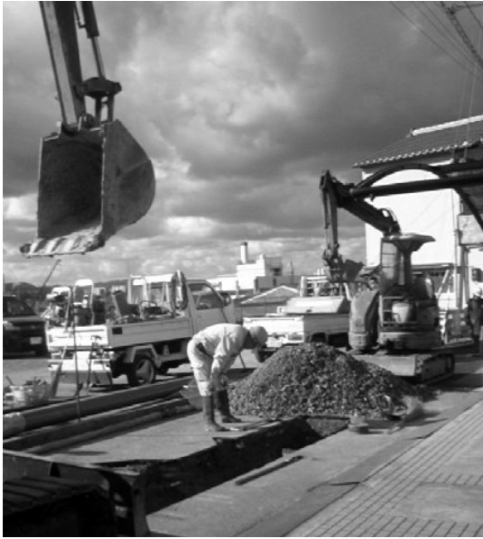
小垣内地区の下水道工事
