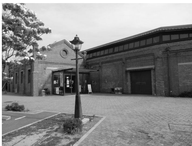
煉瓦館（町指定文化財）写真は熊取町提供
