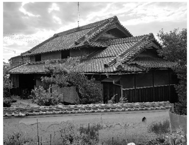
つし2階建・真壁造・黒漆喰塗の例
