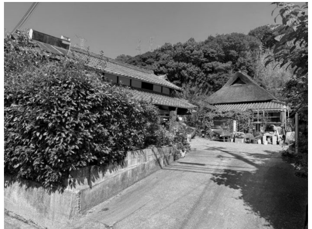
つし2階と茅葺の建物が並ぶ民家
