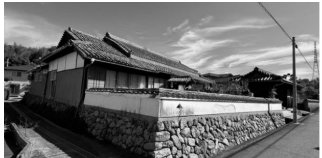
塀に囲われた敷地に建つしころ葺の民家
