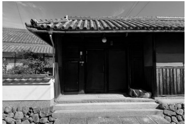
道路拡張で移築された長屋門
