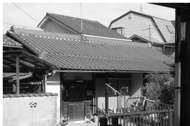
平屋建 しころ葺民家
