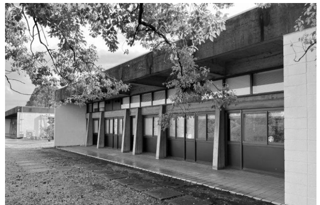
左奥は事務棟、右は図書棟
