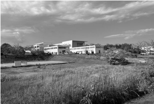
丘陵地に建つ研究棟（倉庫棟・工作棟）
