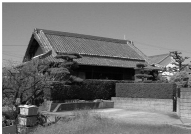
平屋建 しころ葺の住宅
