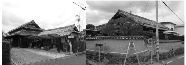
塀に囲まれた前栽・納屋・蔵等付き住宅
