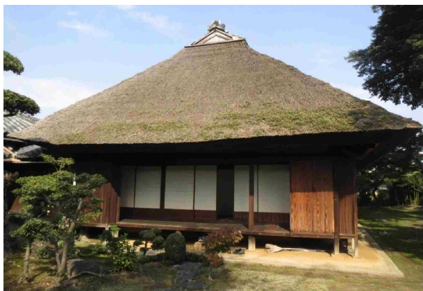
屋根葺き替え前
