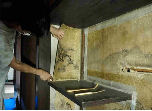
違棚の壁貼付絵の撤去状況（令和3年5月）
