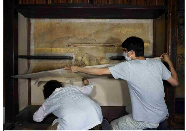
違棚の壁貼付絵の撤去状況（令和3年5月）
