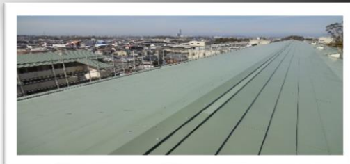
町営住宅災害復旧工事
