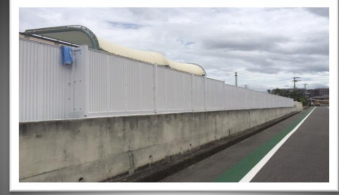
北小学校ブロック塀改修
