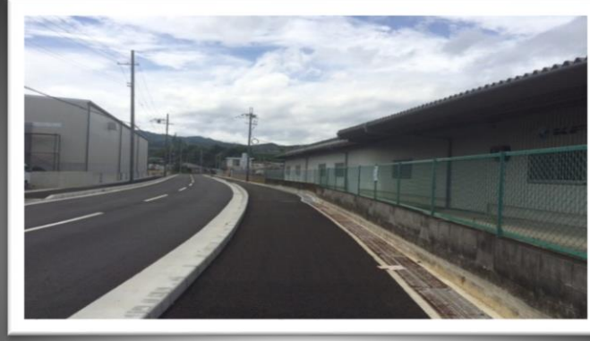
町道小谷穴釜線道路拡幅工事
