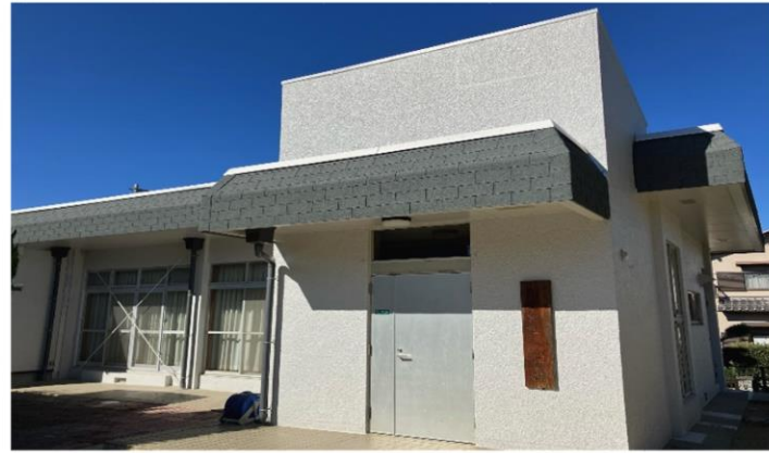
老人憩の家耐震補強工事 2億3,100万円
