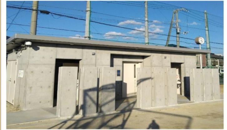
八幡池青少年広場トイレ工事 2,600万円
