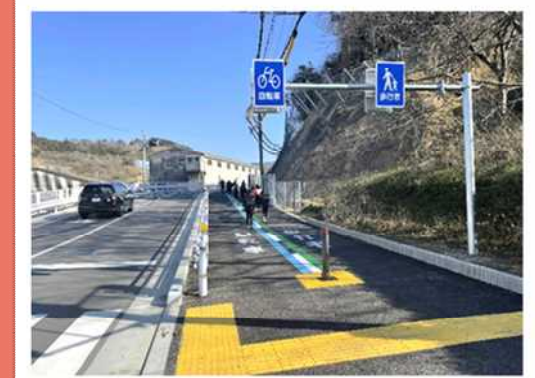
町道久保高田線歩道拡幅工事 9,100万円
