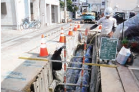
管路の更新・耐震化
