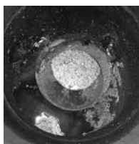
※下水道管の詰まり
