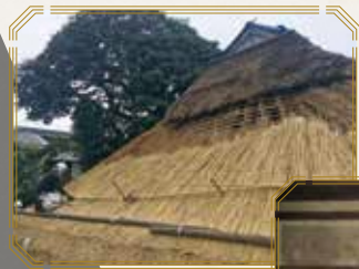
● 茅葺き屋根 葺き替えの様子
